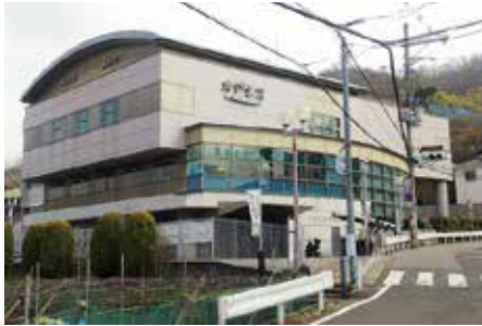
解体予定の 健康福祉センター「オアシス」
