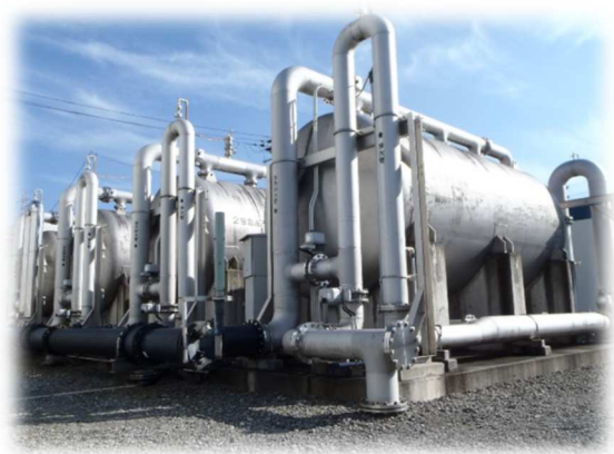
急速ろ過機・膜ろ過装置（玉手浄水場）
