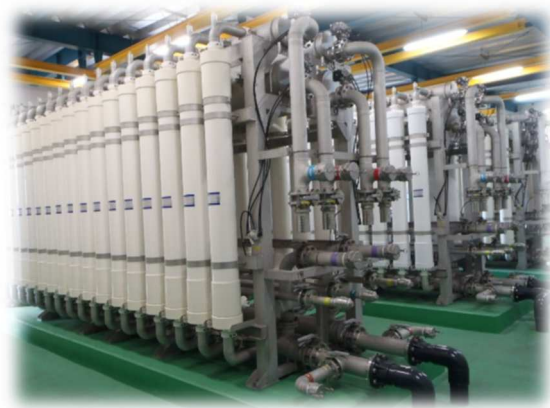
急速ろ過機・膜ろ過装置（玉手浄水場）
