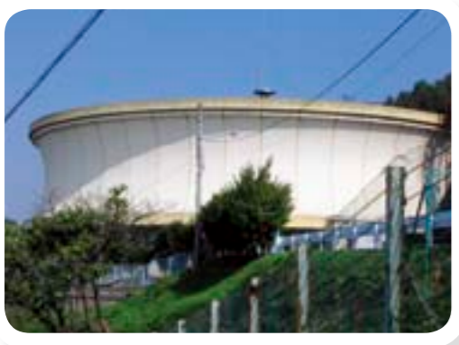
新安堂配水池
