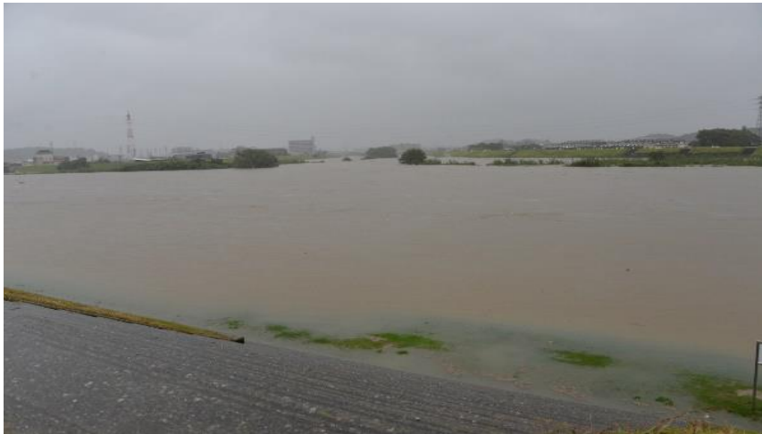
水位が上昇した大和川の様子 平成29年台風21号：柏原市役所前
