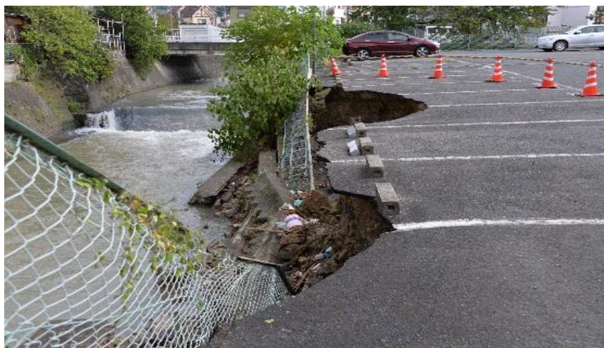
原川の水位上昇に伴う護岸崩壊 平成29年台風21号：柏原市旭ヶ丘
