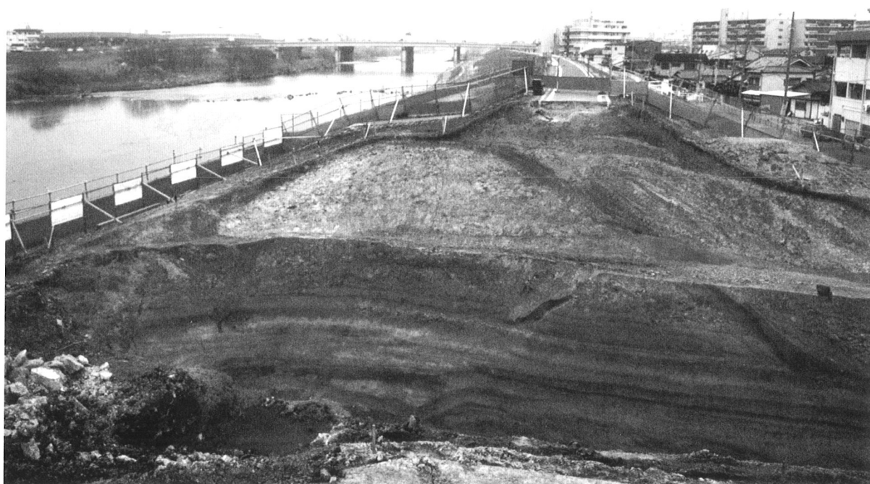
ていぼう 大和川の堤防をつくる ((財)大阪府文化財センター提供)
