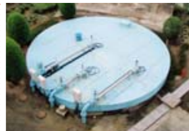
取水井戸 浄水場内外の井戸から原水（地下水）を汲み上げています。
