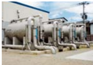
圧力ろ過機 原水中に溶解している鉄・マンガンなどの不純物を除去します。
