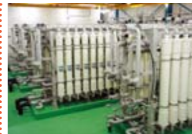
膜ろ過装置 耐塩索性病原微生物や圧力ろ過機で除去できなかった微粒子などを除去します。
