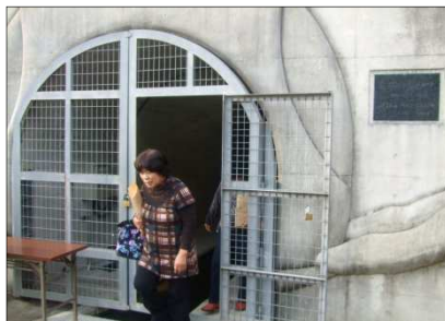
【排水トンネル】
